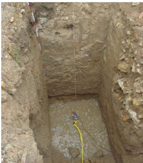
Uso de la bomba para la extracción de agua de un sondeo estratigráfico. Calle La Cilla 2-4. Alcalá del Río, Sevilla, 2006. Foto: Álvaro Fernández Flores
