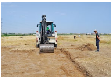
Uso de la retroexcavadora para la limpieza superficial y rebaje de las primeras capas de tierra en una excavación. Cerro Macareno. La Rinconada, Sevilla, 2021. Foto: Francisco José García Fernández
