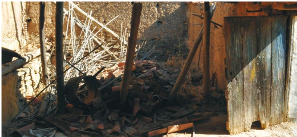
Derrumbe de una cubierta vegetal en el interior de una estructura construida con un cimiento-zócalo de piedra y un alzado de tapial. Restos de un molino harinero junto al Guadiana. Mértola, Portugal, 2016. Foto: Francisco José García Fernández
