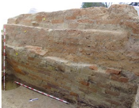
Superposición de muros de carga levantados con ladrillos en adobe pertenecientes a las sucesivas reconstrucciones de una estructura realizada en tierra. El Carambolo. Camas, Sevilla, 2005. Foto: Álvaro Fernández Flores
